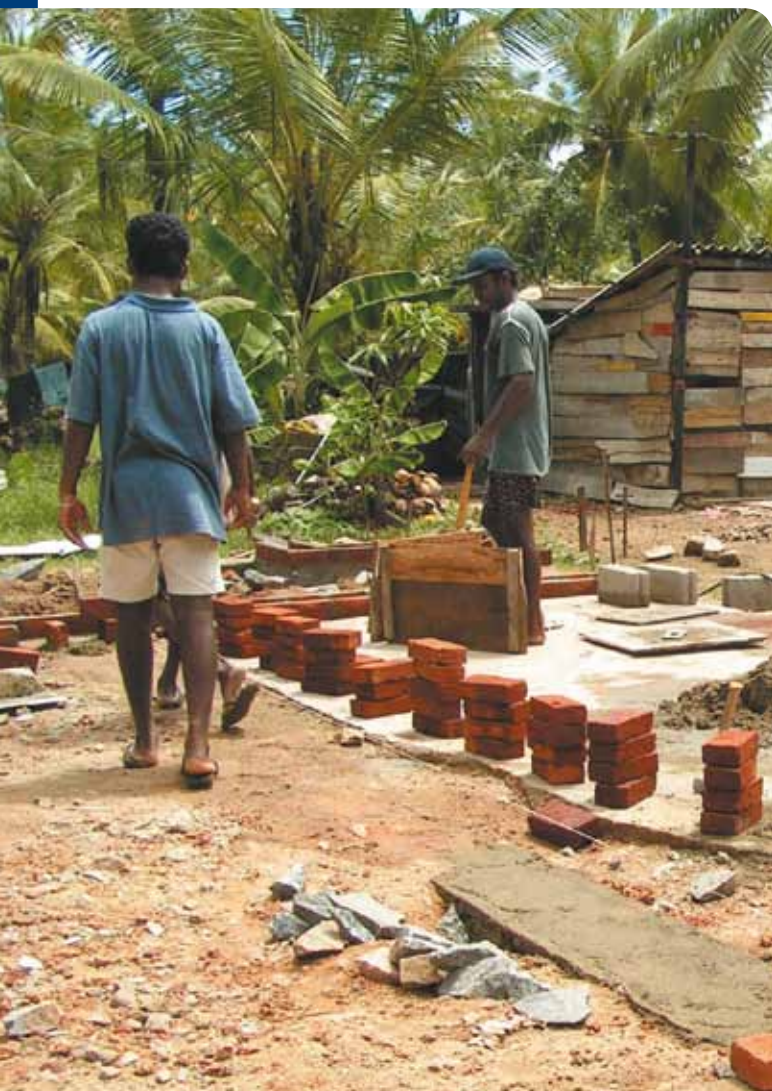
Lors des travaux de reconstruction, les victimes et leur famille mettent aussi la main à la pâte.
