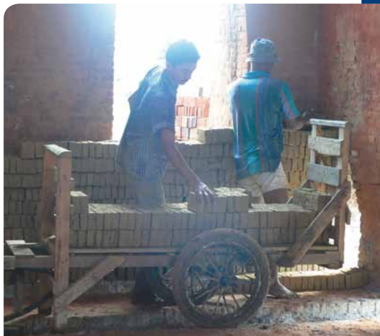
La briqueterie coopérative de KSBSI à Banda Aceh offre de nouveaux emplois et permet la reconstruction de nombreuses habitations pour les travailleurs et leur famille.
